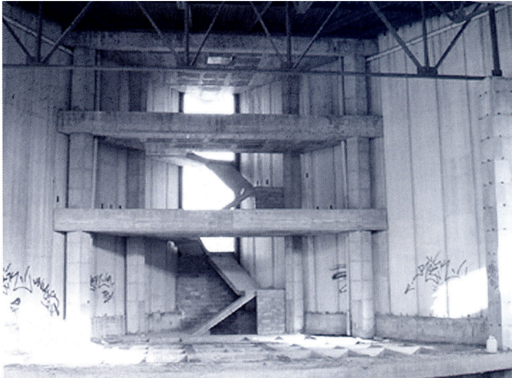
La forma triangular de l'estructura del tercer edifici anticipa l'aspecte del que serà el futur auditori.
